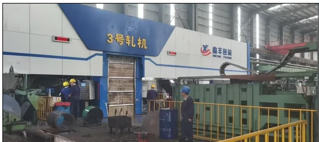
图 2-1 冷轧机组实际建设情况图
