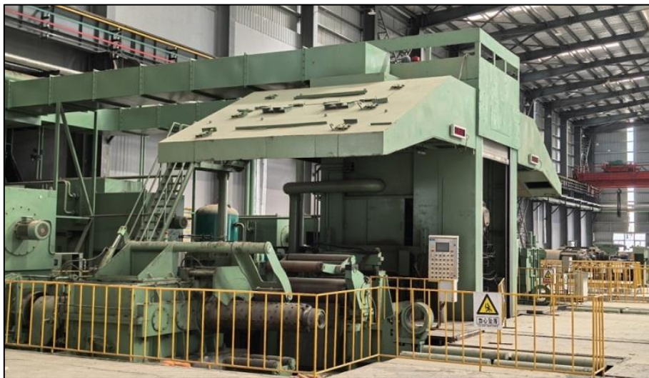
图 2-1 冷轧机组实际建设情况图
